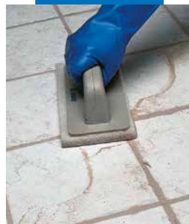
Finition au Scotch-Brite®
