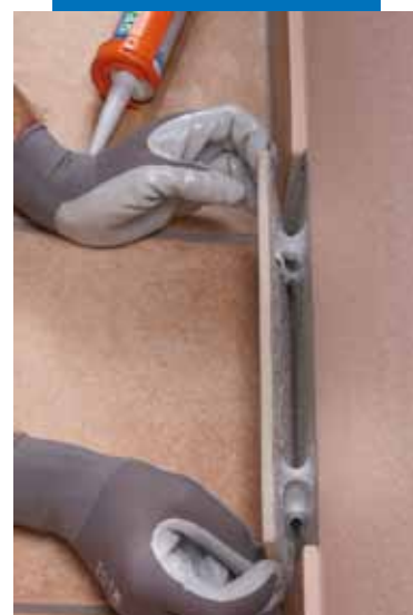
Collage élastique d'éléments de construction
