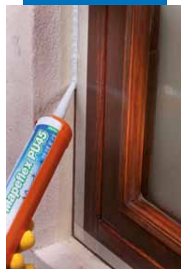
Remplissage de joints de construction
