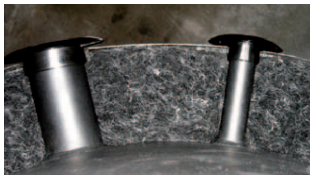
Forme parfaitement ajustée, et donc aucune perte par effet cheminée
