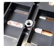
Logement écrou hexagonal M8
